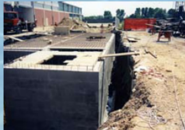
C.Q.S. - Riv. esterno vasca antincendio
